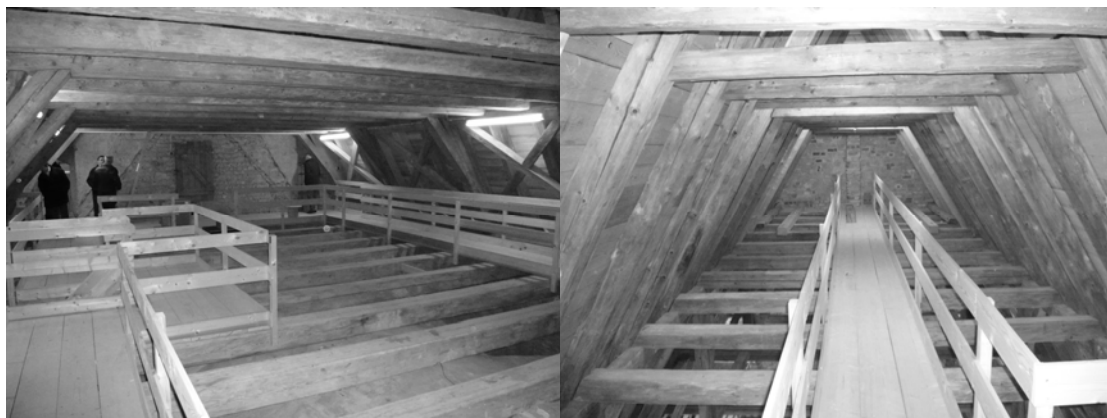
Ein Blick in den renovierten Dachstuhl
