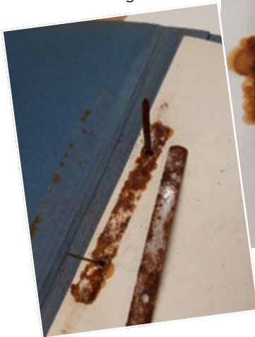
Nicht beabsichtigte Kunstwerke: Rostflecken zerstören die alten Dokumente
